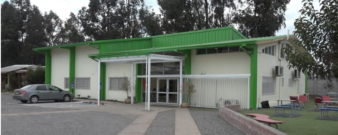
Fotografía N°5: Centro Comunitario de Rehabilitación CCR, Comuna de Chimbarongo
