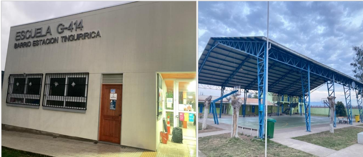
Fotografía N°1: Escuela G-414 Barrio estación Tinguiririca
